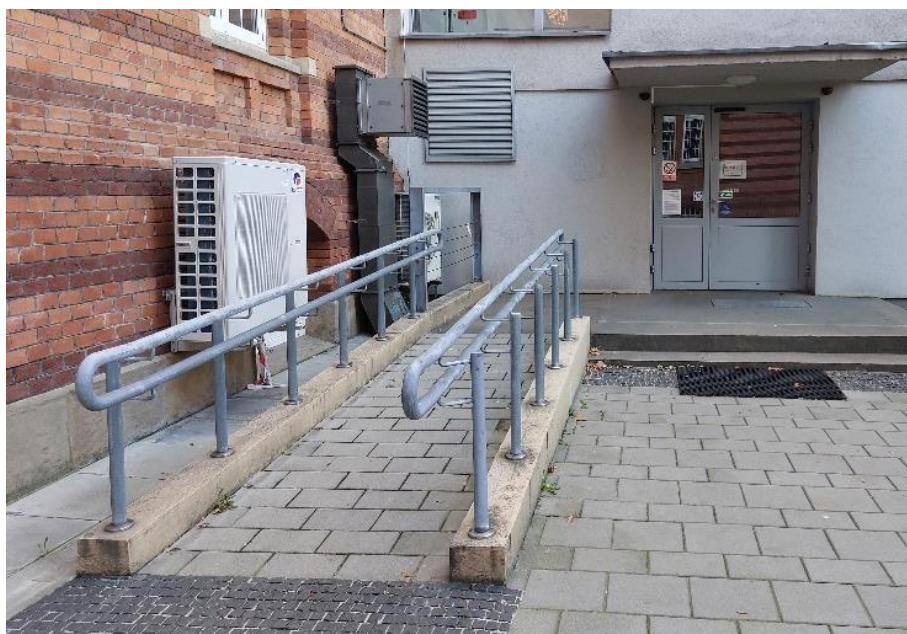
Zdjęcie 10. Podjazd do windy w budynku WIŚiE
