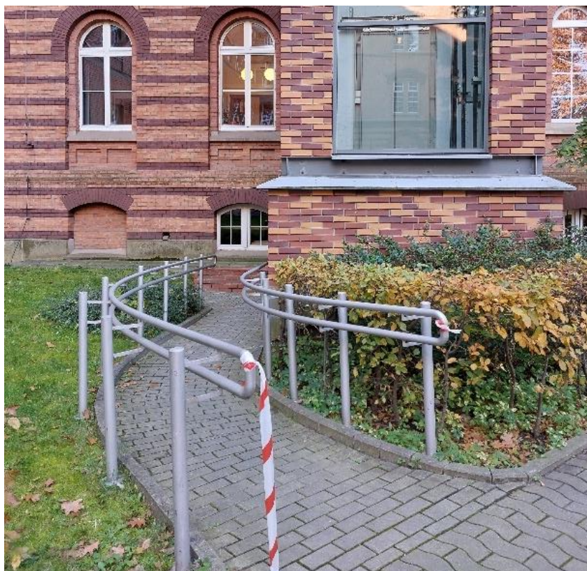
Zdjęcie 7. Podjazd do windy w budynku WIL
