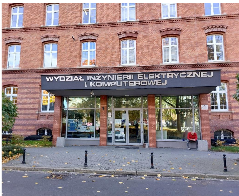
Zdjęcie 13. Wejście główne do budynku WIEiK
